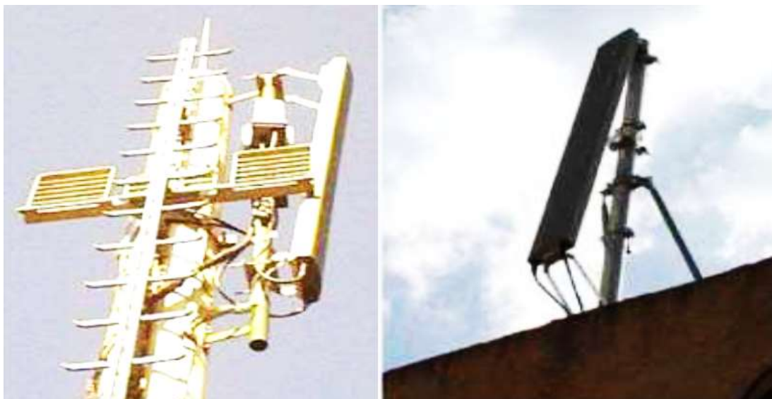
Fig. 40. Antenne directionnelle avec tilt négatif. Antenne directionnelle avec tilt positif
